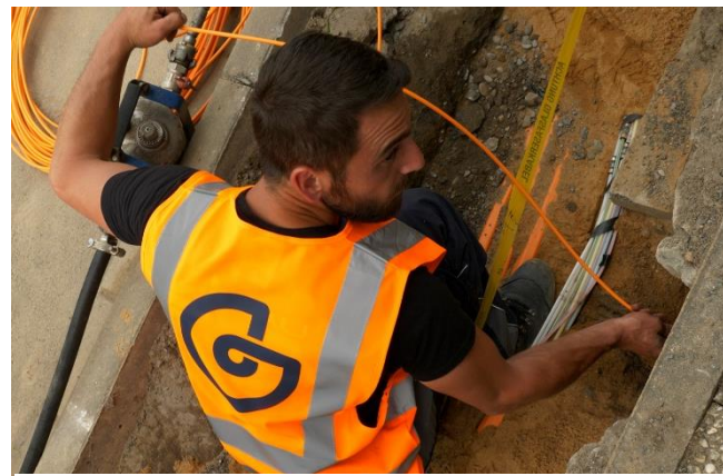
Deutsche GigaNetz informiert über den Bauzwischenstand in Beilstein © Deutsche GigaNetz
